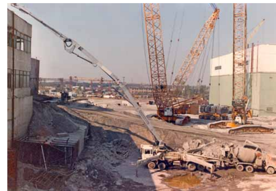
Заливка бетона при строительстве саркофага
