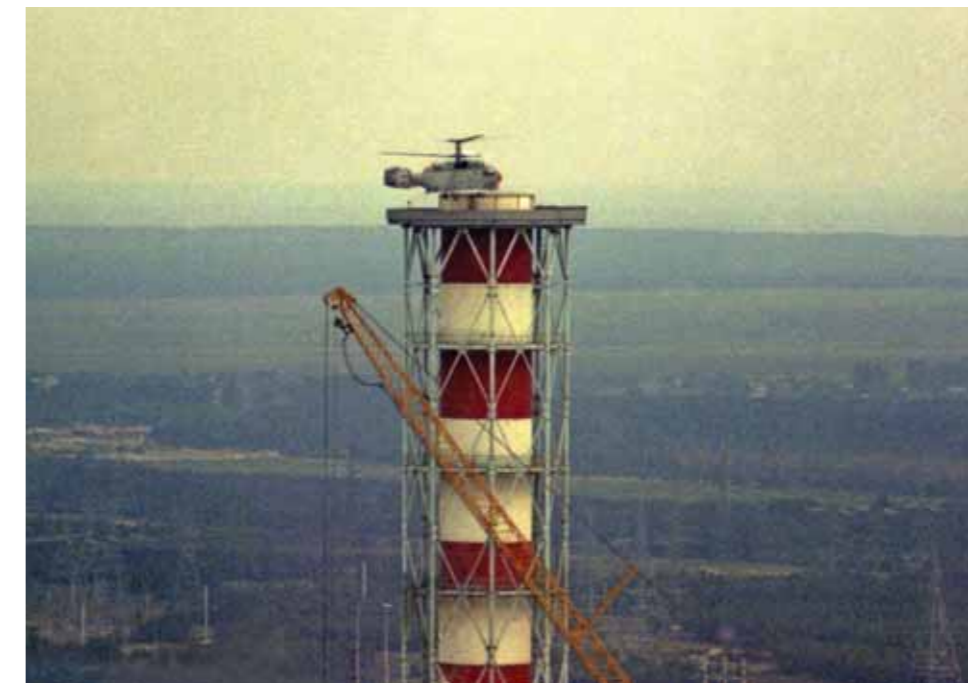
Вертолет ВМФ проводит установку системы контроля мощности дозы в вентиляционной трубе
