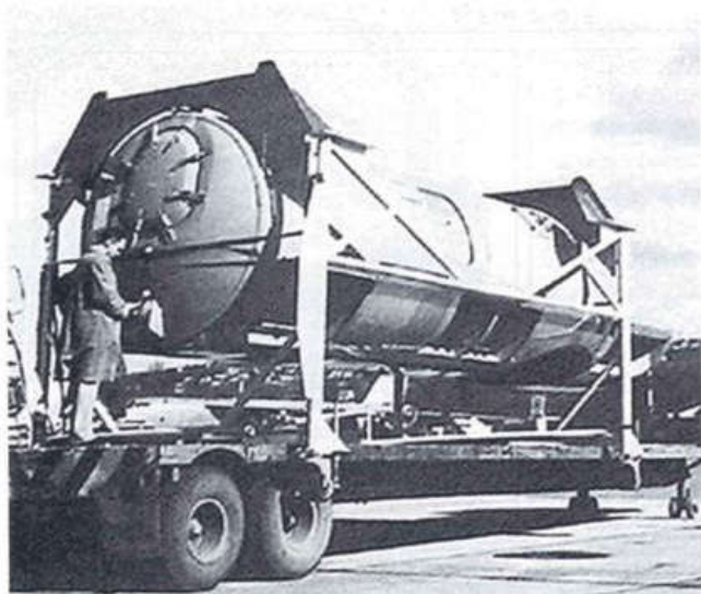
Универсальная капсула с разведывательным, помеховым и метеорологическим оборудованием и рабочими местами его операторов подвешивалась в отсек B-52 вместо вооружения
